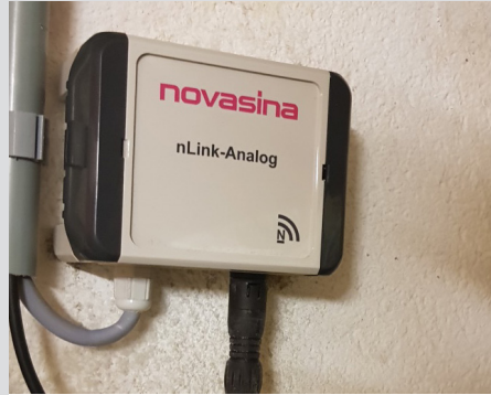
nLink Analog IP Transmitter welcher an der bestehenden Verkabelung angeschlossen wurde.
